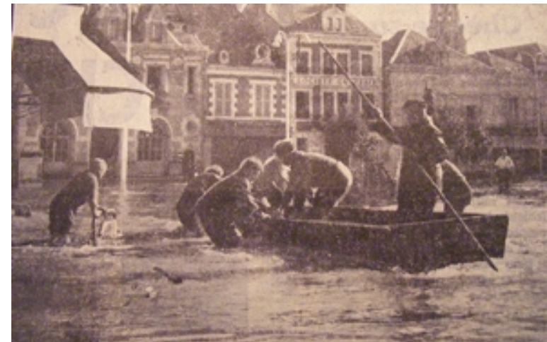
Dans une rue d'Argenton-sur-Creuse, des sauveteurs viennent porter secours à des habitants cernés par les eaux. La Nouvelle République, 5 octobre 1960
